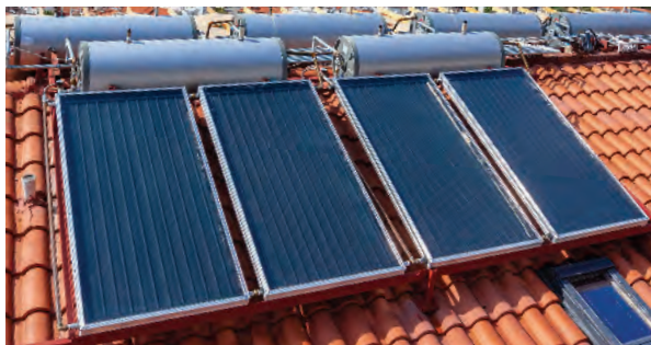
Aquecedor solar sobre o telhado de uma moradia.
