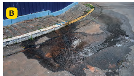
Vazamento em encanamento de distribuição de água, no município de São Paulo, no estado de São Paulo, em 2022.
